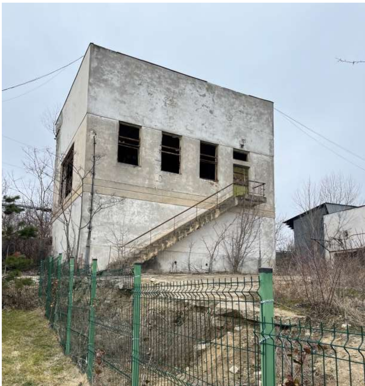
Clădire nr.8 - înălțime 10 m x lățime 9 m
