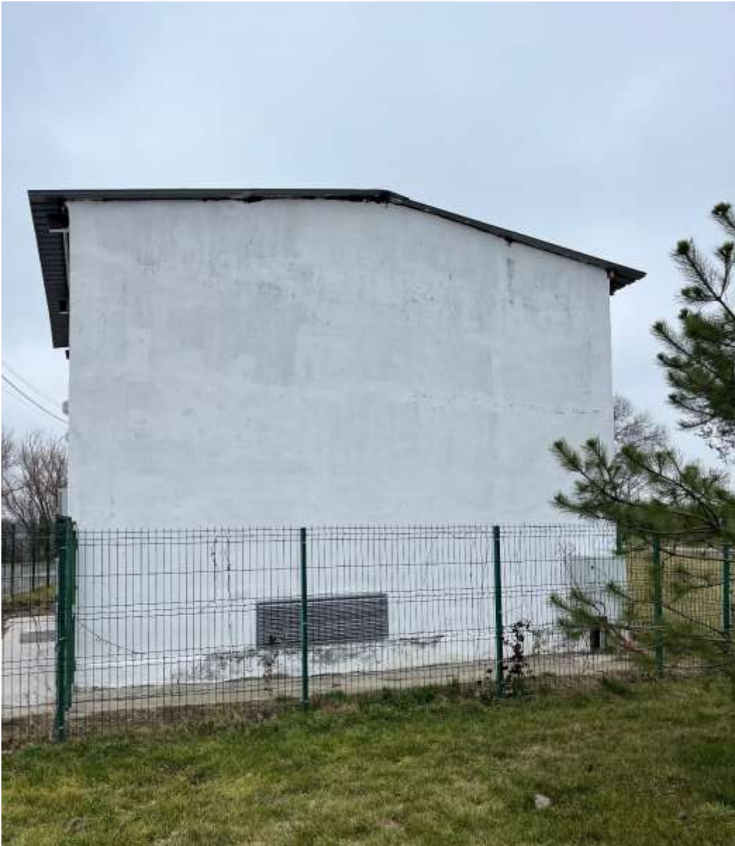
Clădire nr.5 - înălțime 4,6 m x lățime 7 m
