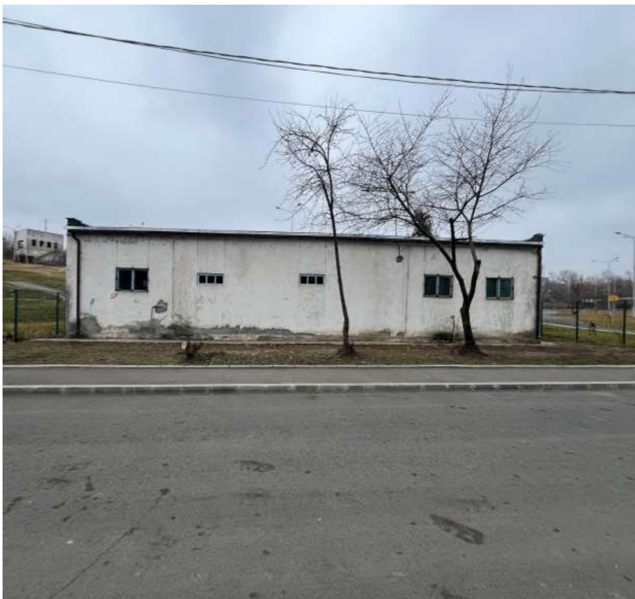
Clădire nr.4 - înălțime 3,6 m x lățime 16 m
