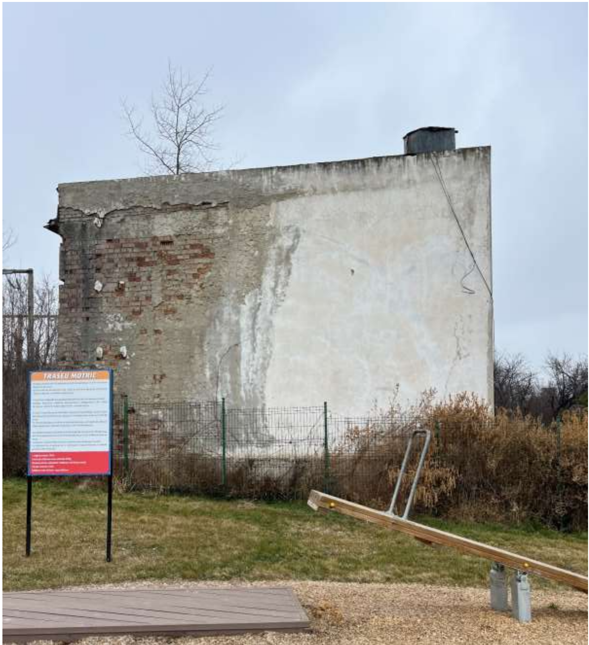
Clădire nr.7 - înălțime 9 m x lățime 6 m
