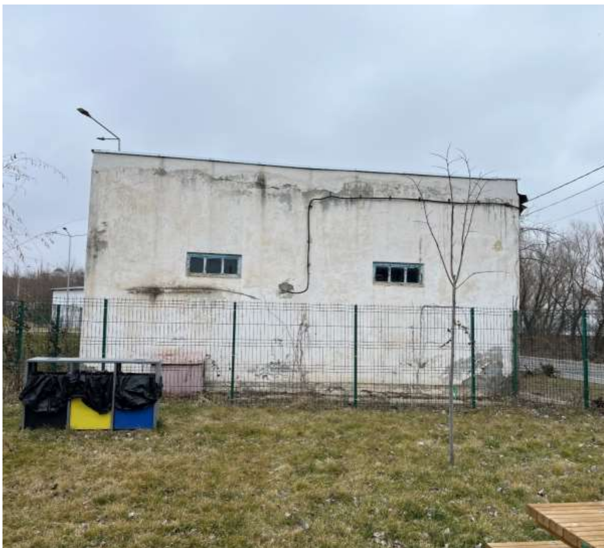
Clădire nr.3 - înălțime 4 m x lățime 7,8 m
