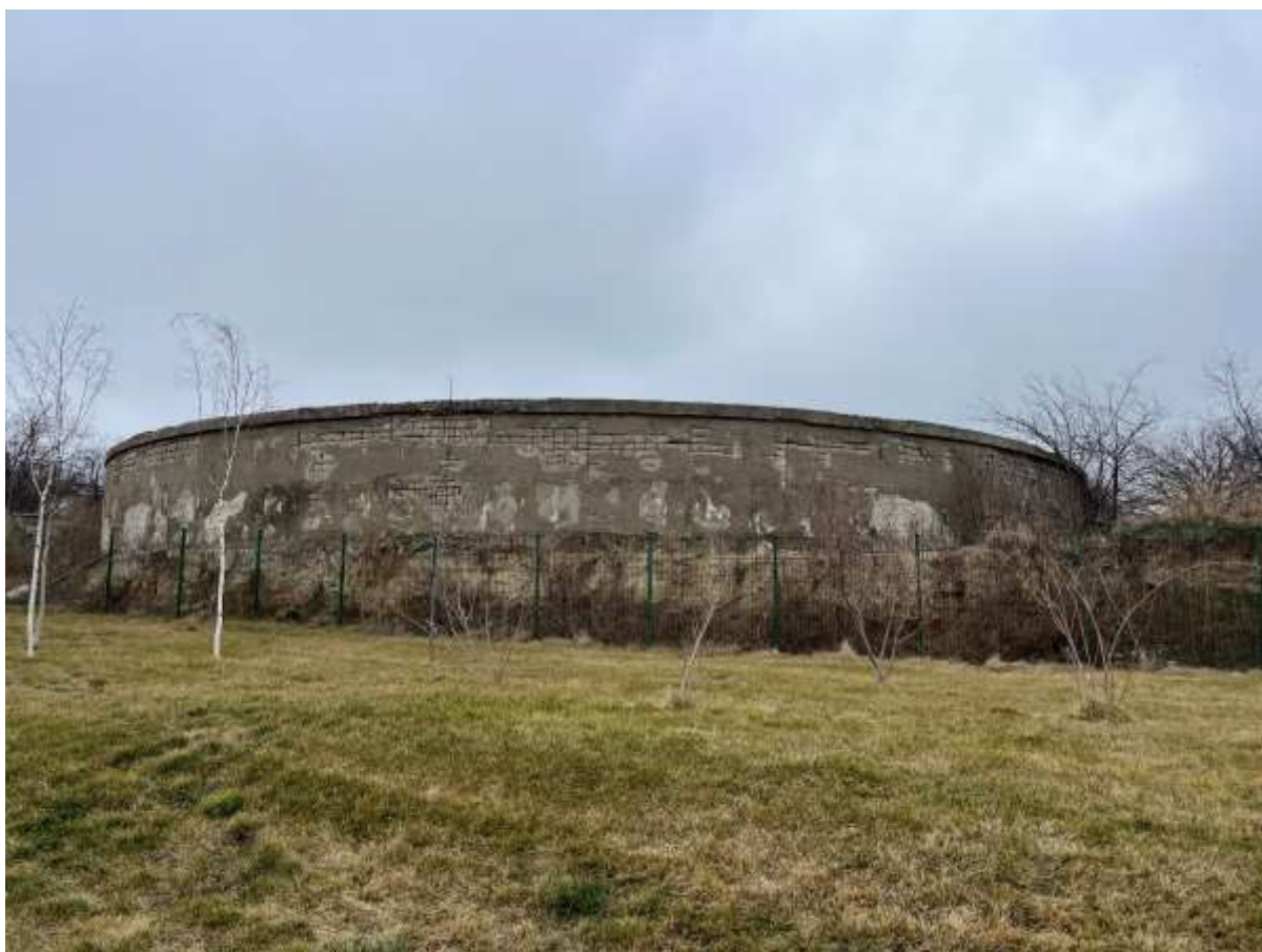
Clădire nr.1 - înălțime 2,3 m x lățime 30 m
